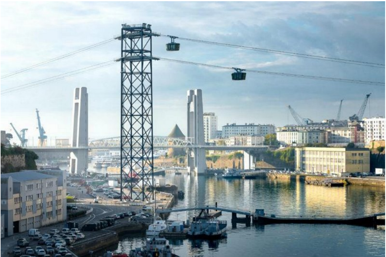
L'exemple du téléphérique urbain à Brest inauguré en novembre 2016 et qui peut transporter 1.200 passagers par heure. / © Source: europe-en-france.gouv.fr
