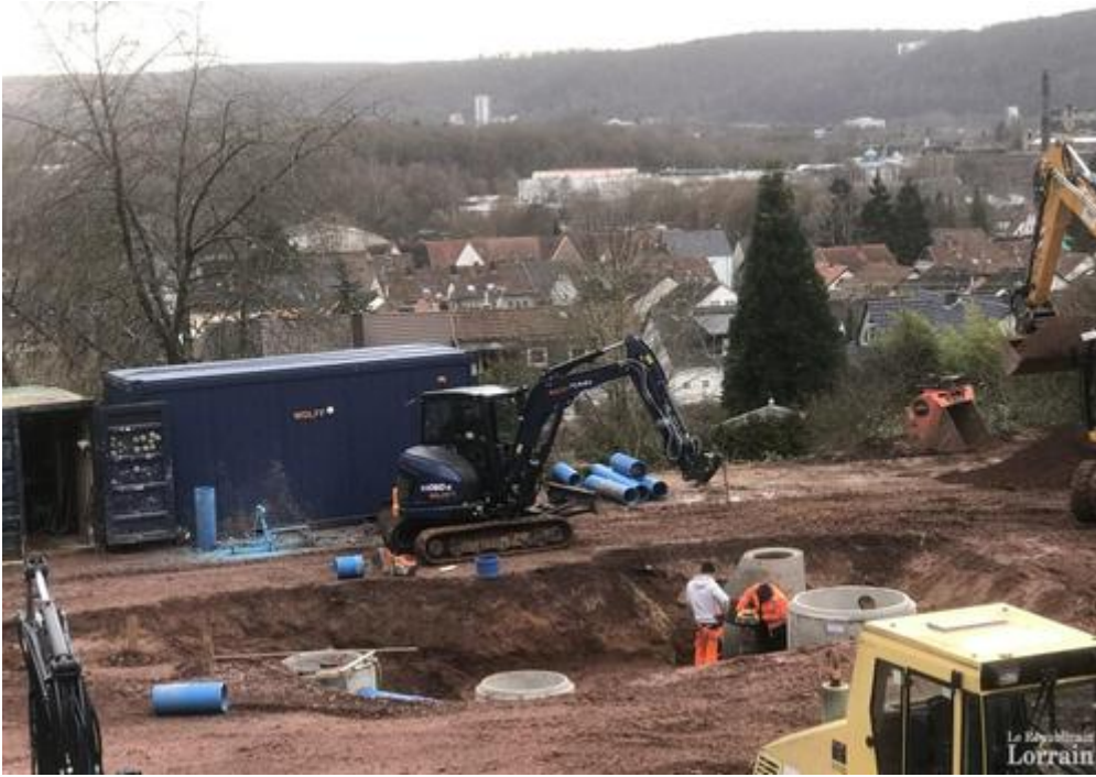
La future crèche transfrontalière sera située à 12 km de Sarreguemines. Le chantier en est au stade du terrassement et de la pose des canalisations par la société Wolff. Son ouverture est prévue pour septembre 2023. Photo RL /Nicolas THIERCY
