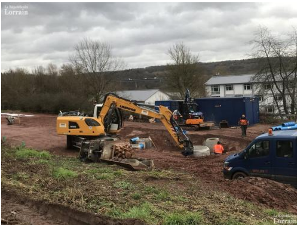
Le chantier de la crèche transfrontalière a démarré dans le quartier de Brebach, à Sarrebruck. La pose symbolique de la première pierre est prévue ce vendredi 4 février. Photo RL /Nicolas THIERCY
